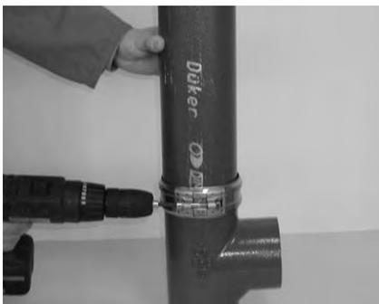
**3.** При помощи торцевого ключа туго затянуть винт с внутренним шестигранником, по возможности до соединения обоих зажимных кулачков (усилие затяжки см. в описании хомута).
