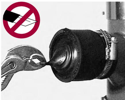
**2.** При помощи клещей захватить и аккуратно оторвать заглушку так, чтобы отверстие стало свободным.
