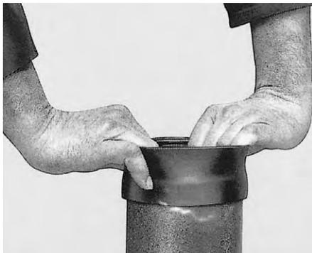
**1.** Прежде всего наденьте резиновое уплотнение на нижнюю трубу так, чтобы буртик резинового уплотнения лег на торец трубы.
