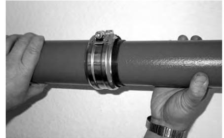
**3.** Вставить конец SML трубы DN 70 с надетым на неё отрезком шланга в хомут DN 80.
