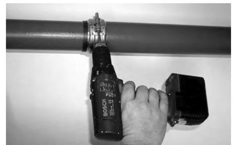
**4.** Затянуть болт на хомуте Dükorapid® (момент затяжки 10-20 Нм)
