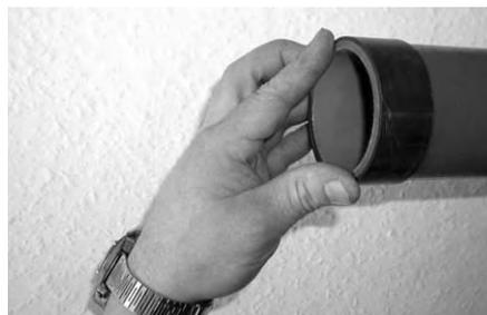
**2.** Надеть отрезок шланга 74/79 на конец соединяемой трубы или фитинга SML DN 70.
