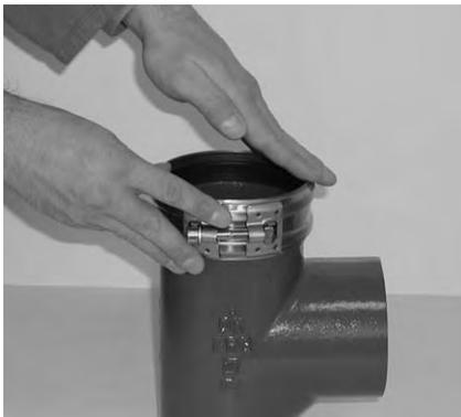
**1.** Поставляемое в комплекте хомутное соединение надеть на край трубы до упора буртика.
