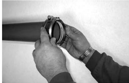
**1.** Надеть соединительный хомут Dükorapid® DN 80 на трубу или фитинг SML DN 80.
